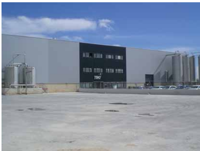
Le site TSC de Tarancón a été construit en 2007
