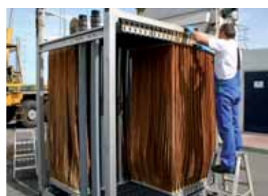
Golcza : mise en place des membranes d'ultrafiltration
