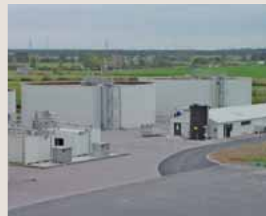
Le site de Bayet (station d'épuration)
