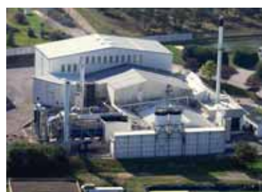
L'usine de Guer (France) est équipée d'un système d'oxydation des buées de cuisson (au premier plan)
